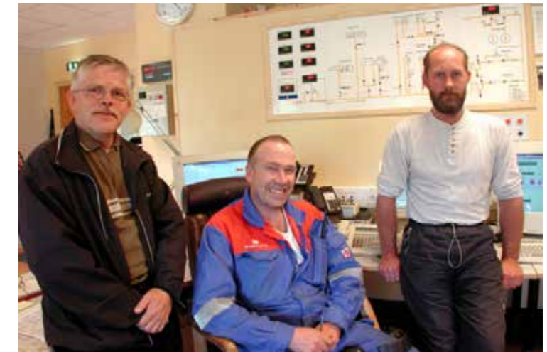
Kontrollrommet på Energisentralen i 2001. Fra venstre Magnar Johansen, Rolf Sivertsen og Eilif Nermark.
